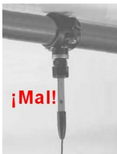
Montaje incorrecto de sondas
