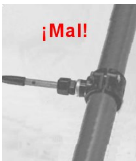
Montaje incorrecto de sondas
