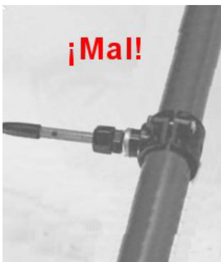
Montaje incorrecto de sondas
